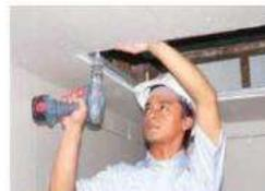
Sekrupkan papan di BMSys Furring Channel / Ceiling Batten tambahan dengan jarak 300mm (center to center).
