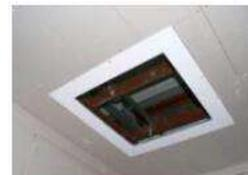
Pasang **Jaya-Access** ke BMSys Furring Channel / Ceiling Batten tambahan dengan jarak sekurup 200mm (center to center). Untuk hasil yang maksimal gunakan kompon UB pada sambungan.
