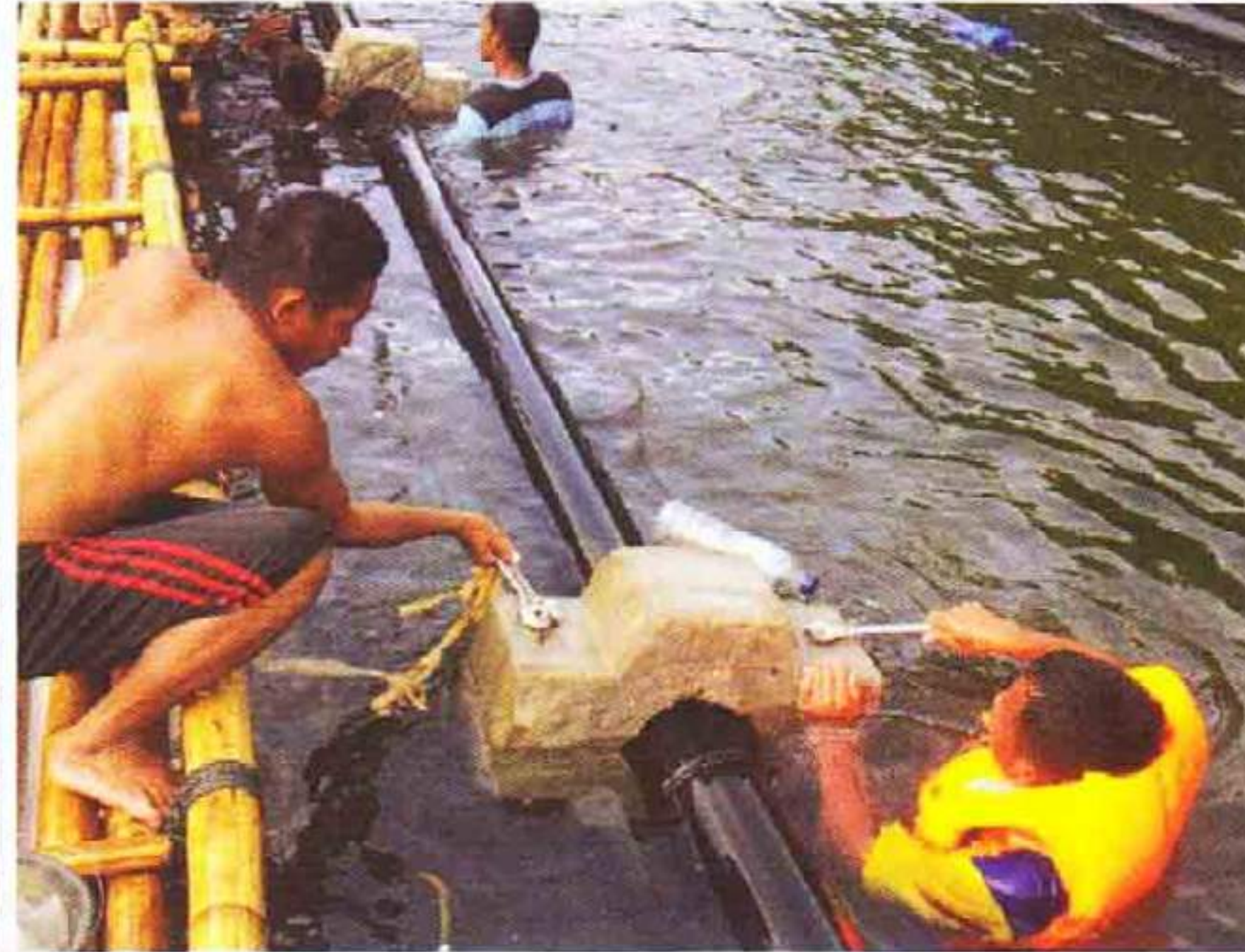
Instalasi Pipa Bawah Laut Kota Mamuju, Pulau Karampuang, Sul Bar
