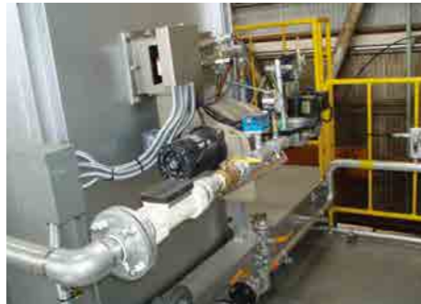
塗装乾燥炉設置例 AG-40S 最大消費量：LPG 33kg/h、13A 37m 3 /h
