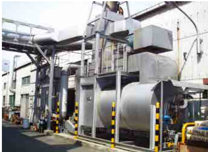
KPD-100 (処理風量100Nm 3 /min) 最大消費量：LPG 83kg/h、13A 93m 3 /h
