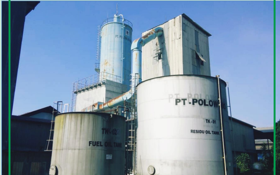
MAGFERTIL PLANT 1 Kapasitas 45.000 Ton/Tahun
