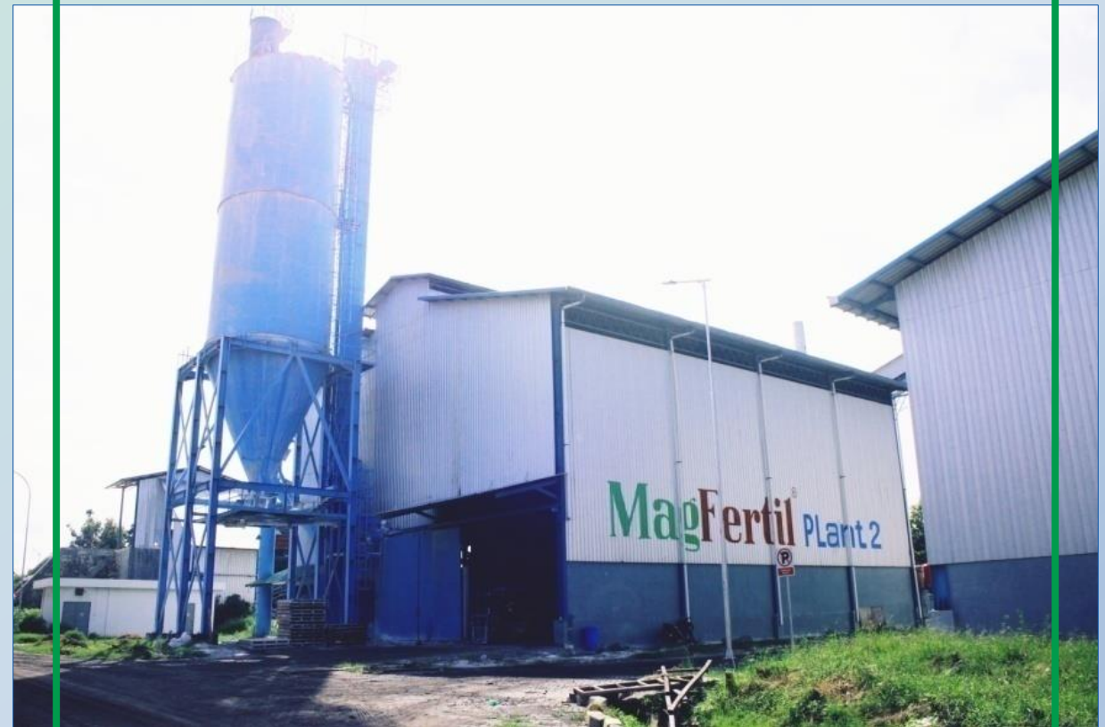
MAGFERTIL PLANT 2 Kapasitas 100.000 Ton/Tahun
