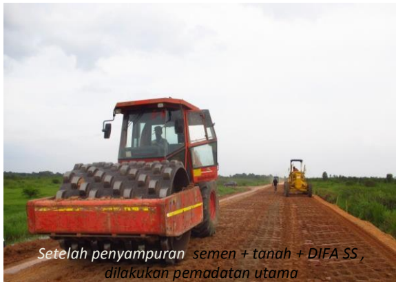
Penyampuran semen-tanah (dry mix)
