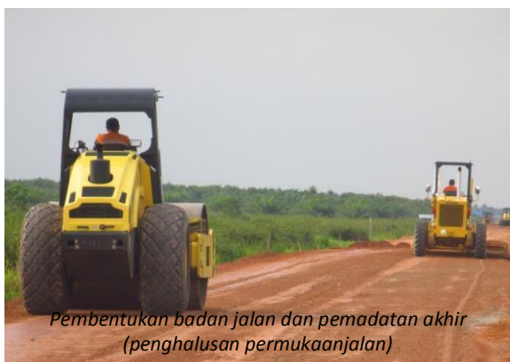
Setelah penyampuran semen + tanah + DIFA SS, dilakukan pemadatan utama
